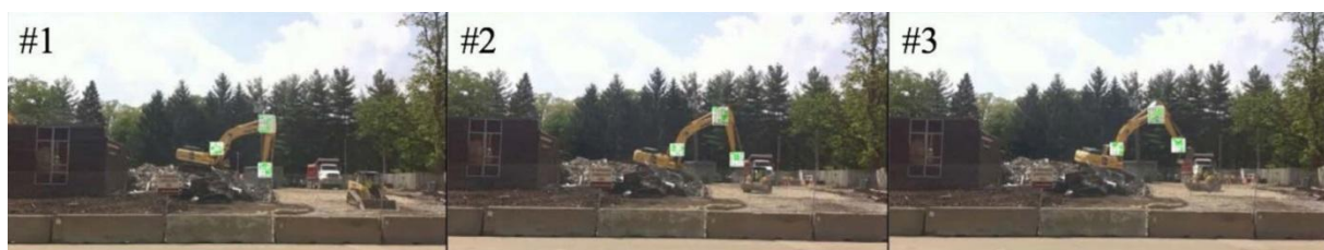
Slika 4. Primjer praćenja ruke i lopate bagera (preuzeto i uređeno: Yuan i dr., 2016)
