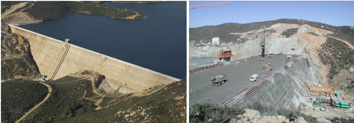
Slike 15.-16. UB brana Olivenhain u SAD (lijevo); velika brzina ugradbe UB na istoj brani (desno) 29
