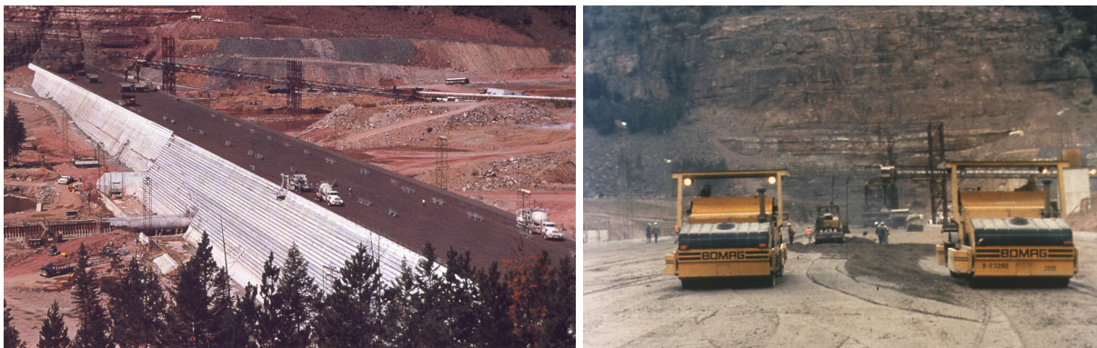
Slike 11.-12. Ugradba UB na UB brani Upper Stillwater, SAD 23,29
