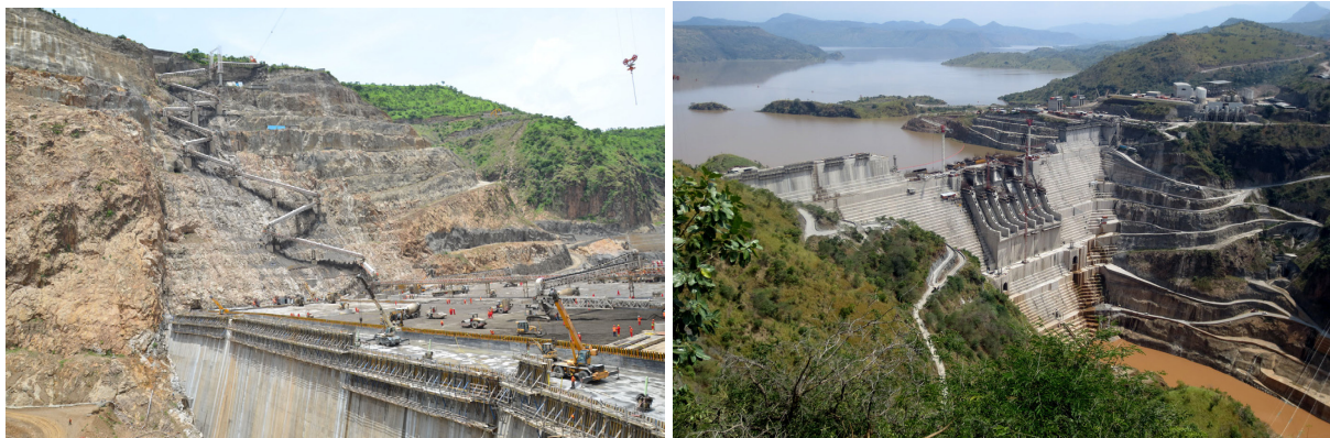
Slike 27.-28. UB brana Gibe III u Etiopiji, najviša UB brana u svijetu: Ugradba UB (lijevo); pogled na najvišu UB brana na svijetu (desno) 29
