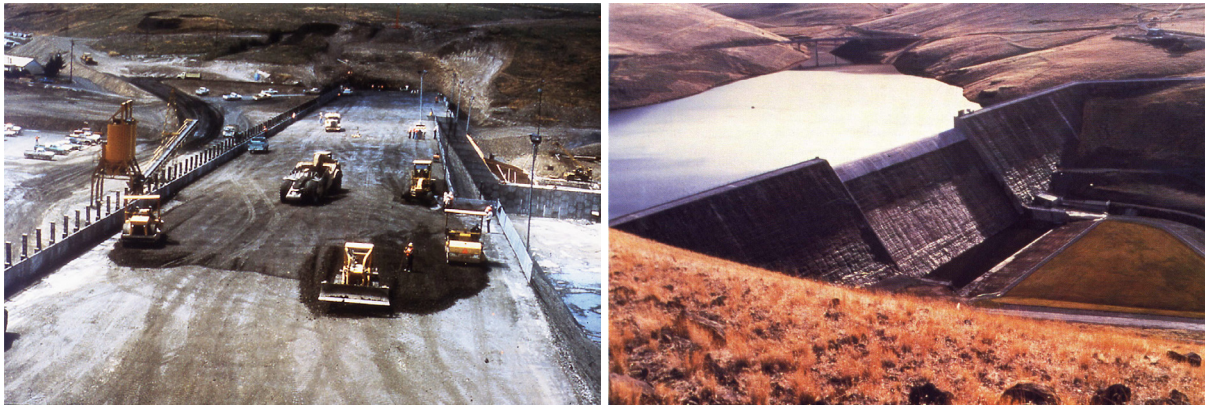
Slike 5.-6. Brana Willow Creek, SAD, prva UB brana u svijetu izgrađena potpuno od UB: Detalj građenja (lijevo); pogled na izgrađenu branu (desno) 29
