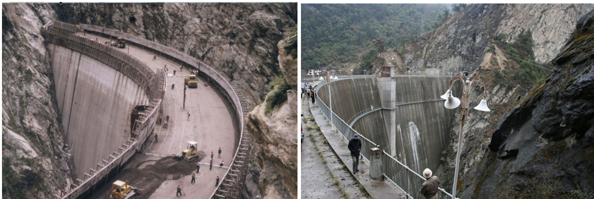
Slike 13.-14. Brana Shapai u Kini: ugradba UB (lijevo); završena brana (desno) 29
