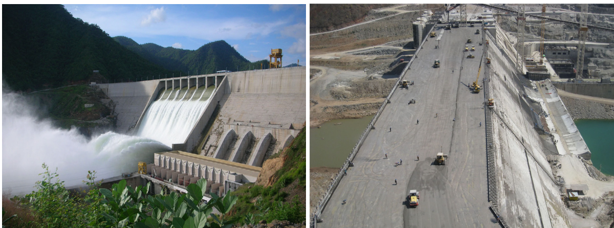
Slike 17.-18. UB brana Yeywa u Myanmaru: pogled (lijevo), detalj ugradbe UB 1 etaža dnevno preko cijele površine brane, što je povećalo brzinu ugradbe UB 29
