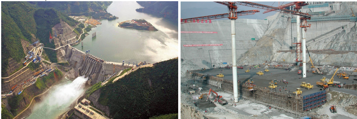
Slike 25.-26. UB brana Longtan u Kini: pogled (lijevo); detalj ugradbe UB (desno) 29
