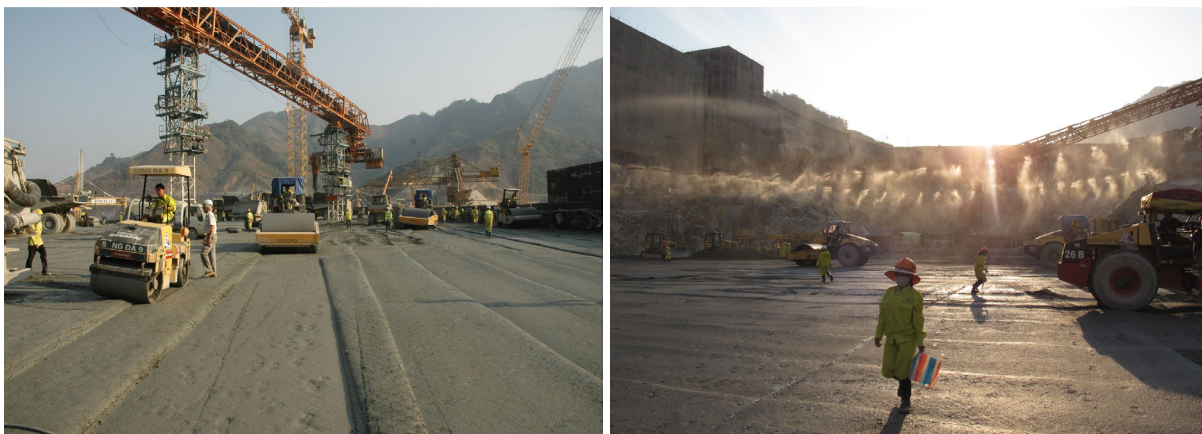
Slike 23.-24. Ugradba UB: UB brana Son La (lijevo) i UB brana Lai Chau (desno) 29
