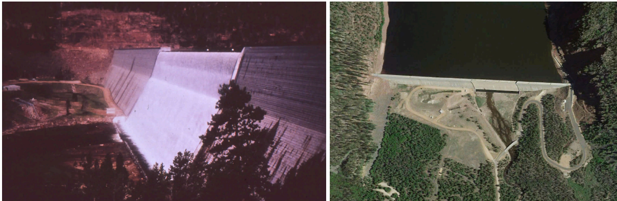
Slike 9.-10. Brana Upper Stillwater, SAD: detalj preljeva (lijevo); pogled iz zraka (desno) 29
