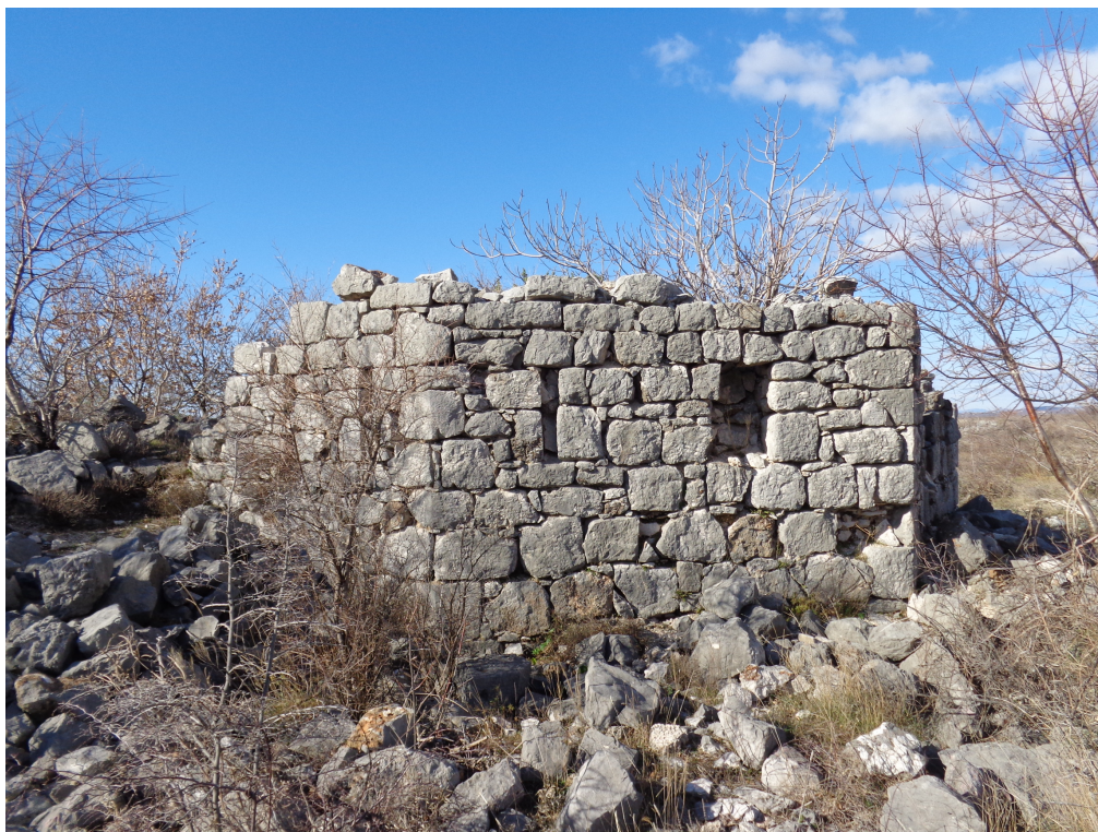
Slika 23. Detalj zarušene platforme Wh Ošanić
