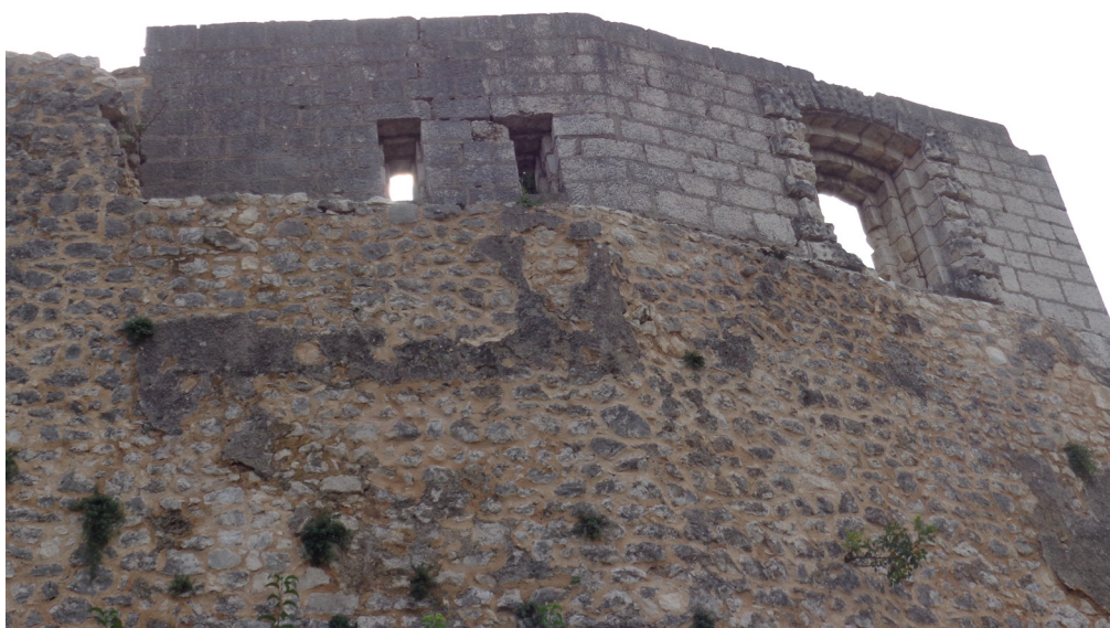
Slika 11. Zapadna topovska platforma sa vanjske strane. Vidljiva je gradnja na starijim zidinama. Desno je otvor za topništvo, lijevo su dvije puškarnice
