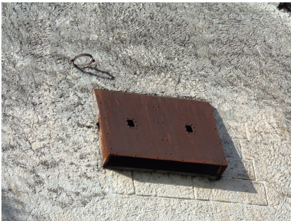
Slika 28. Detalj metalne mašikule u krovštu
