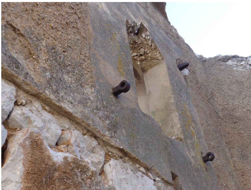
Slika 25. Detalj unutarnje strane toparnice sa ostacima nosača kliznih metalnih štitnika
