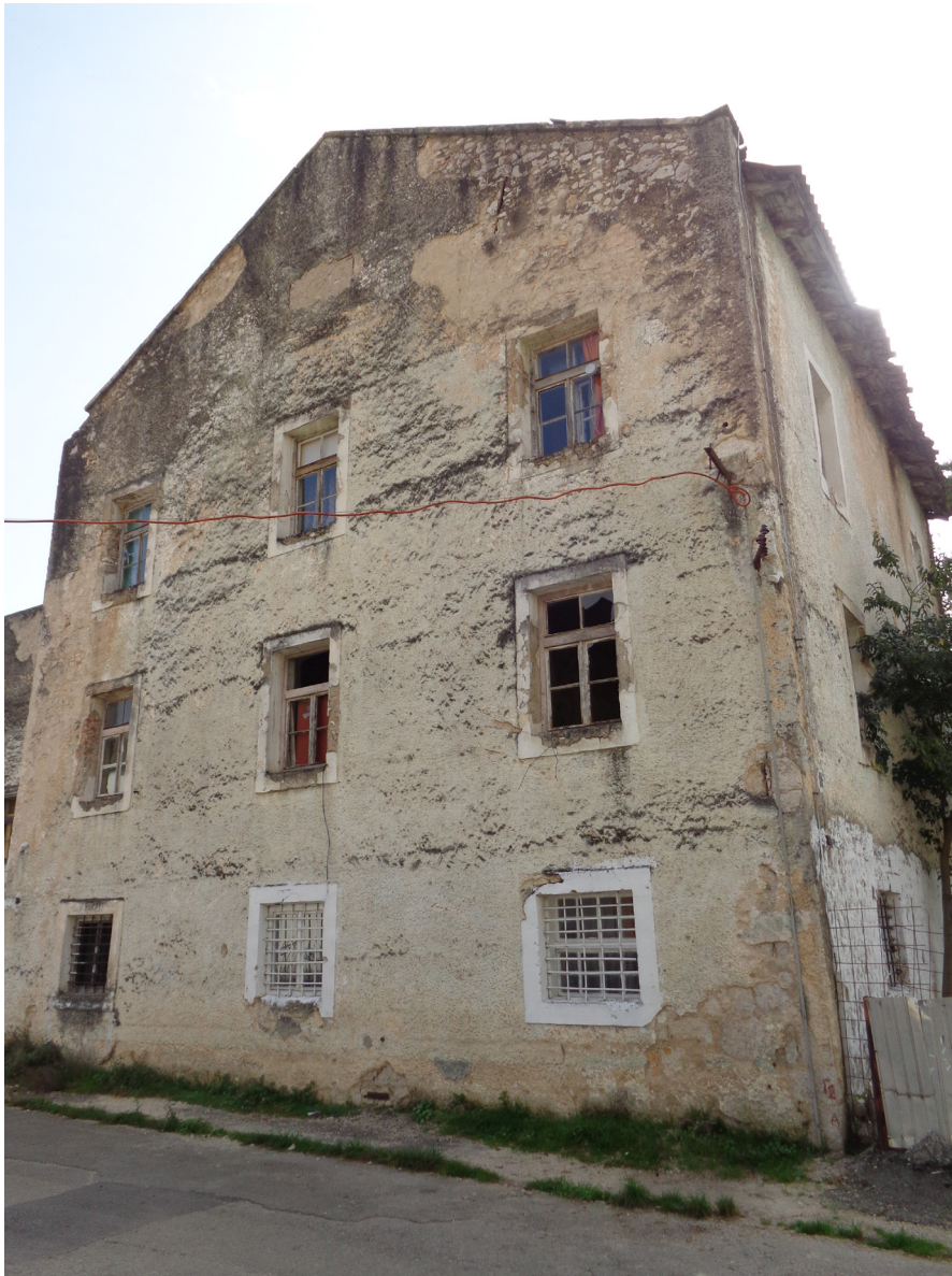
Slika 26. Vanjski dio istočnog pročelja defanzivne vojarne u Stocu
