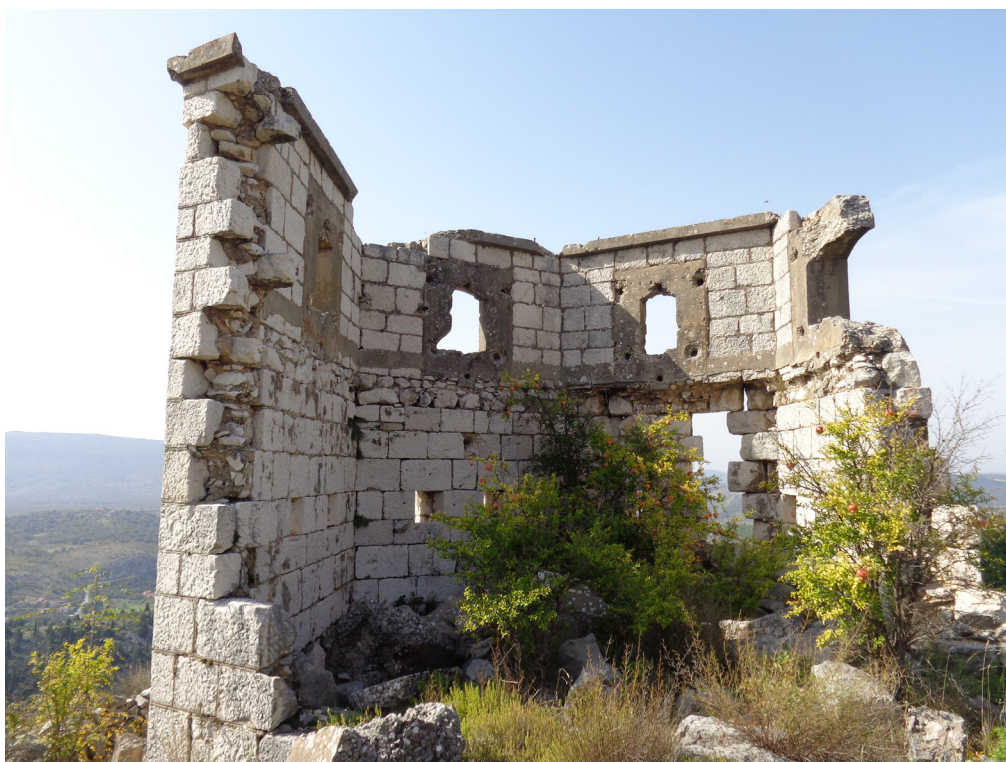
Slika 17. Pogled na platformu sa unutarnje strane
