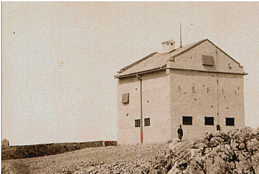
Slika 15. Wachhaus Komanje Brdo prije izgradnje topovskih platformi. Na zidovima su vidljive 2 metalne mašikule. U pozadini se vidi Wachhaus Ošanići
