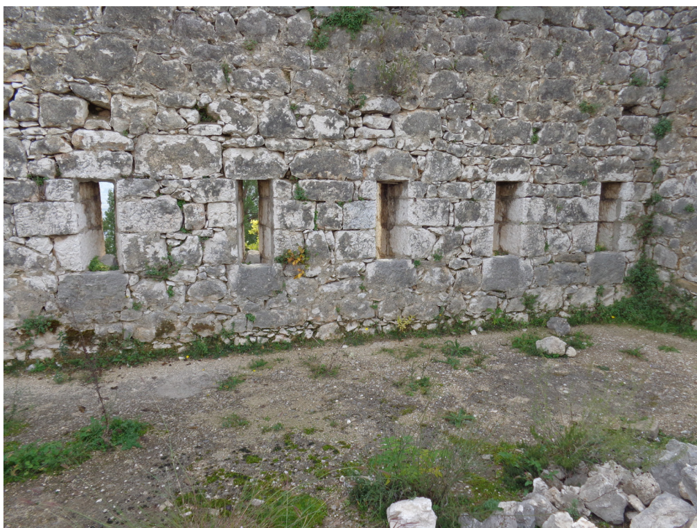
Slika 9. Puškarnice na zidu utvrde
