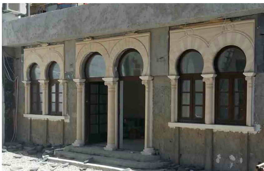
Slika 50. Oblaganje „miljevinom“ objekta u Mostaru (foto: M. Golemac, „Revigrad“)
