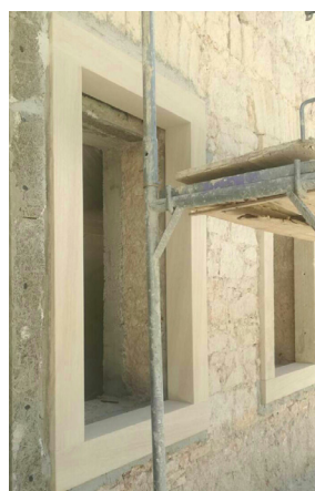
Slike 47.-48. Detalji obnove zgrade Samostana na Širokom Brijegu „miljevinom“ (foto: M. Golemac, „Revigrad“)
