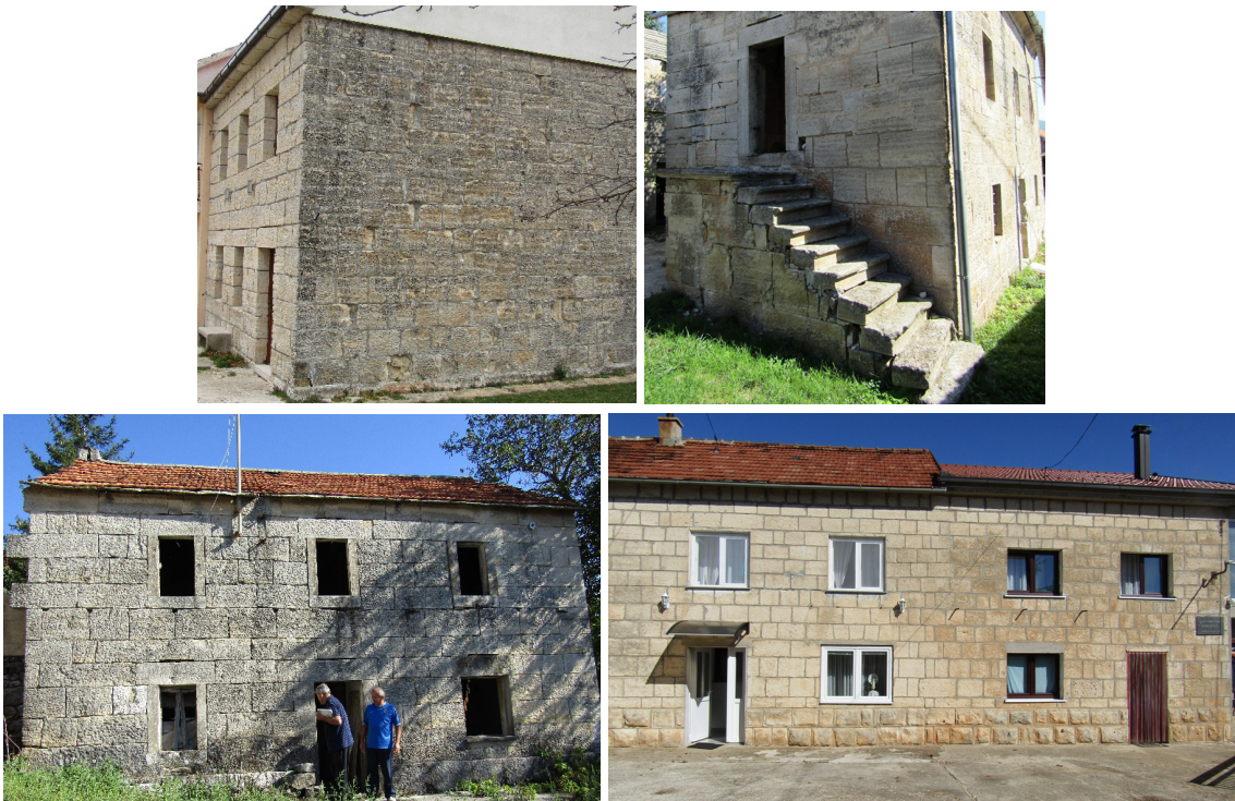
Slike 33.-36. Stambeni objekti na više lokaliteta u općini Posušje, građeni od kamena „miljevina“ (foto: K.Šaravanja)
