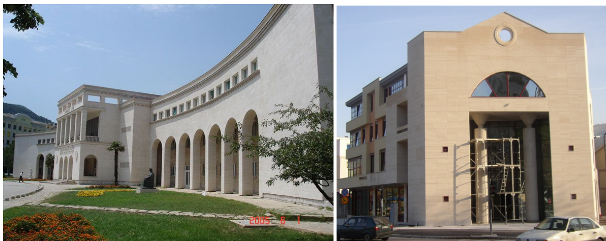
Slike 44.-45. Objekti u Mostaru oblagani „miljevinom“: Hrvatski dom „Herceg Stjepan Kosača“ (lijevo); Pročelje poslovne zgrade „Sivrić“ (desno)
