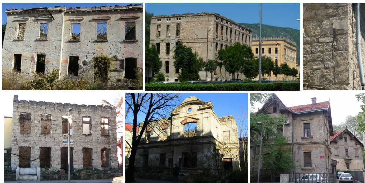
Slike 38.-43. Neke javne građevine u središtu Mostara građene od „miljevine“ s fasadom (gore, lijevo i sredina) (foto: K. Šaravanja); Detalj kamenog zida sa potresnom zategom Crkve u Blagaju (gore, desno) 39 ; Brojne stambene građevine u središtu Mostara od „miljevine“ sa fasadom (dolje) (foto: K. Šaravanja)
