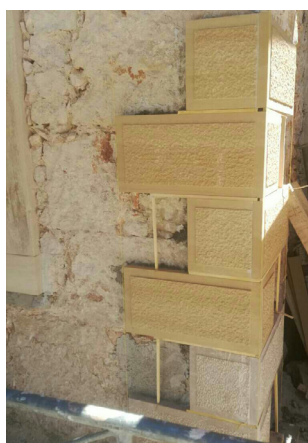
Slike 47.-48. Detalji obnove zgrade Samostana na Širokom Brijegu „miljevinom“ (foto: M. Golemac, „Revigrad“)
