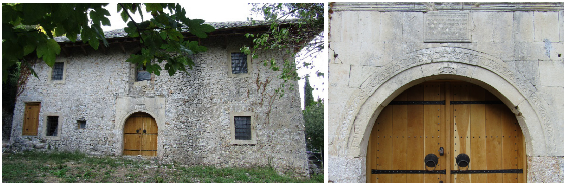
Slike 28.-29. Južna fasada Biskupske rezidencije, nacionalnog spomenika BiH (lijevo), s detaljem ulaznog portala od slatkovodnog vapnenca (desno) (foto: K. Šaravanja) 32
