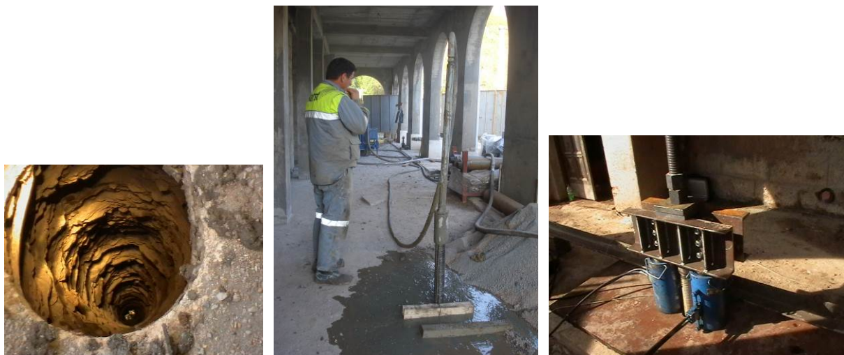
Slika 7. Izrada probnog pilota i ispitivanje nosivosti pilota
