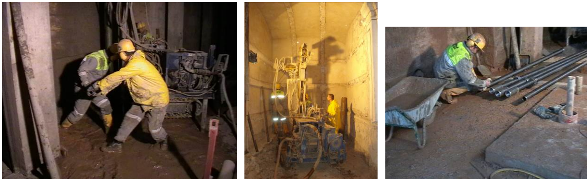
Slika 8. Izrada pilota - Fotodokumentacija
