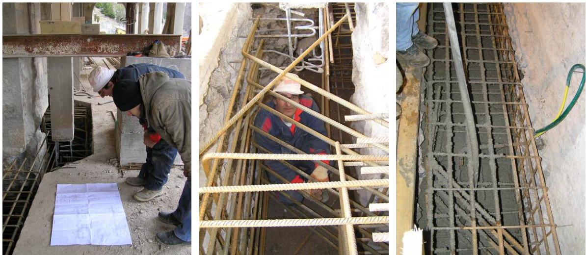
Slika 11. Armiranje i betoniranje NG pilota - Fotodokumentacija
