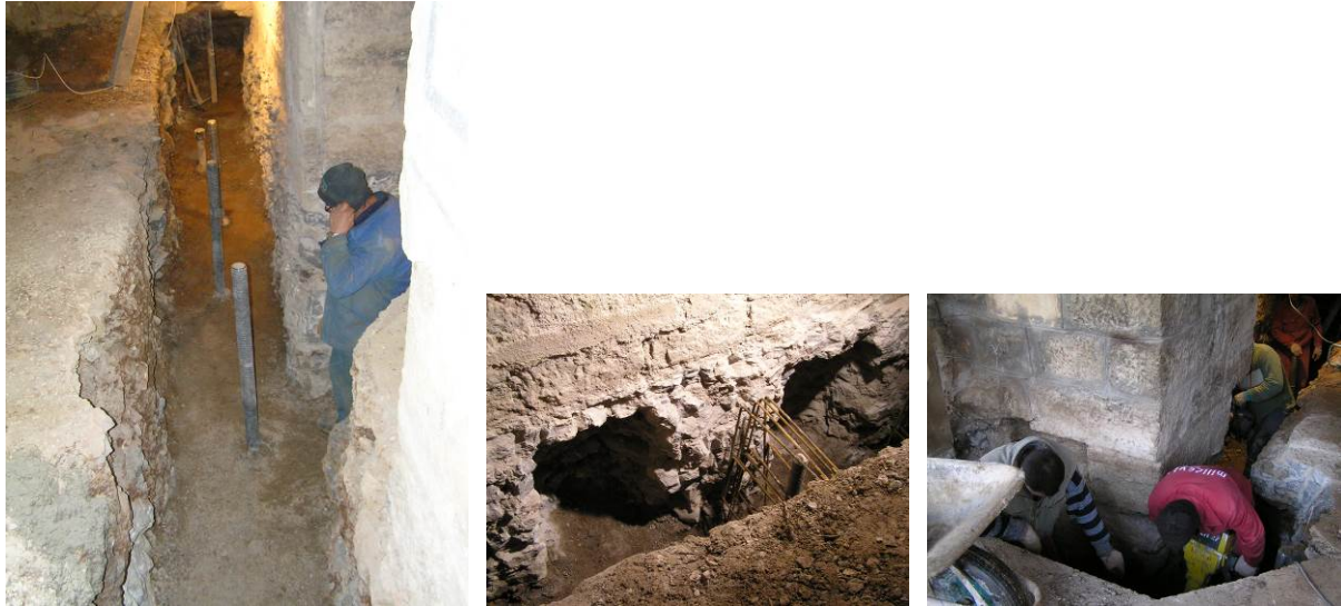
Slika 10. Iskop rova za NG pilota - Fotodokumentacija
