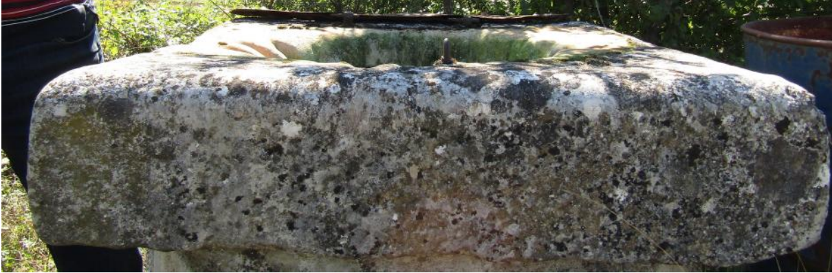
Slika 41. četverokutna kamena kruna stare šatrnje od kamena miljevine u polju u Kovačima kod Posušja (foto: Krešimir Šaravanja)
