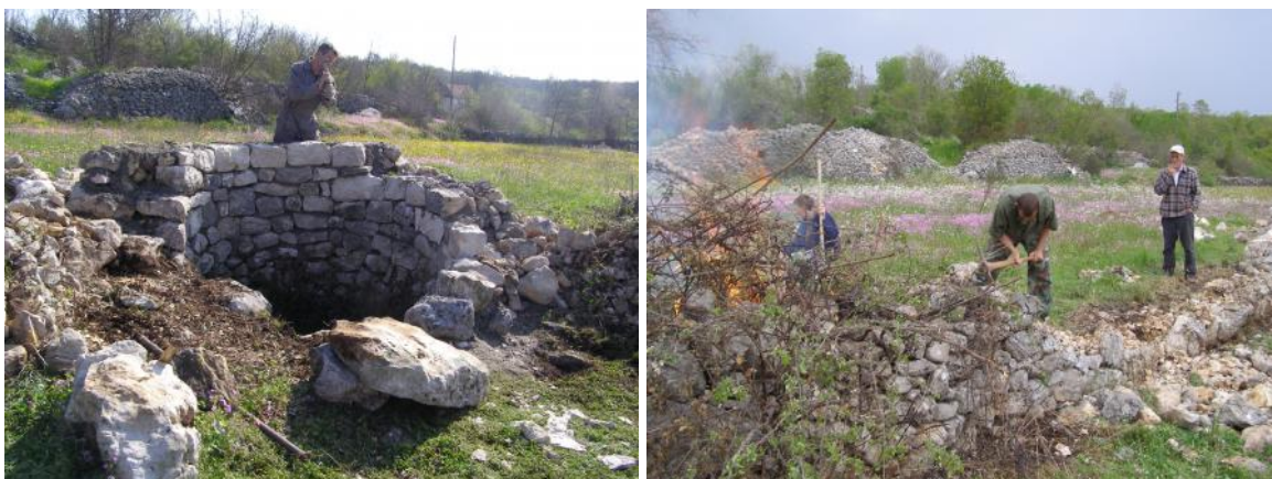
Slike 56.-57. Radovi na obnovi bunara Bistirna (foto: Ivan Dugandžić)
