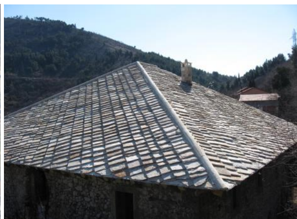
Slike 63.-64. Obnova četverostrešnog krova sa kamenim pločama na Biskupskoj rezidenciji u Vukodolu, Mostar (lijevo), sa detaljom obnovljenog krova (desno) (foto: prof. Mladen Glibi)
