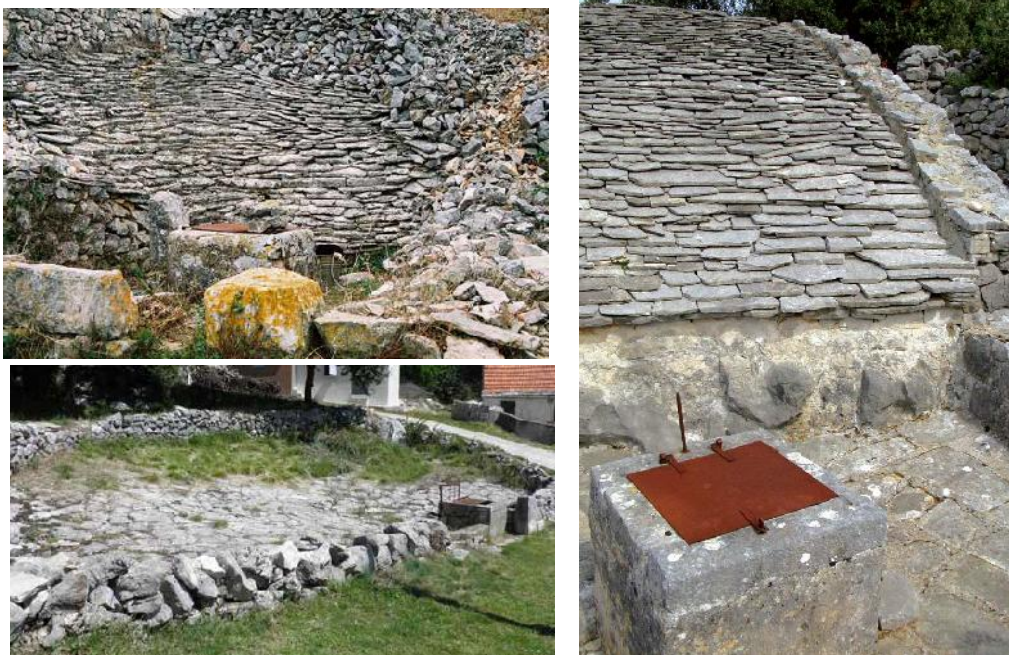
Slike 38.-40. Naplovi (pjoveri), odnosno površine za skupljanje vode, raznih oblika i građevine 19,20
