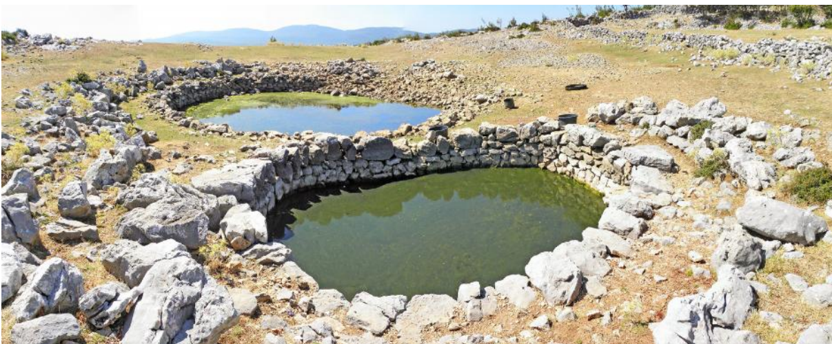
Slika 27. Dvostruka grška lokva kod sela Golubi sjeverno od kanjona Krupe. Manja (sjeverna) lokva, uredno podgrađena suhozidom i s 2 konzolne stepenice za pristup vodi, je otkrivena i bila je za ljude, a ona veća, sa slobodnim pristupom, za stoku (Izvor: www.dragodod.org ) 16
