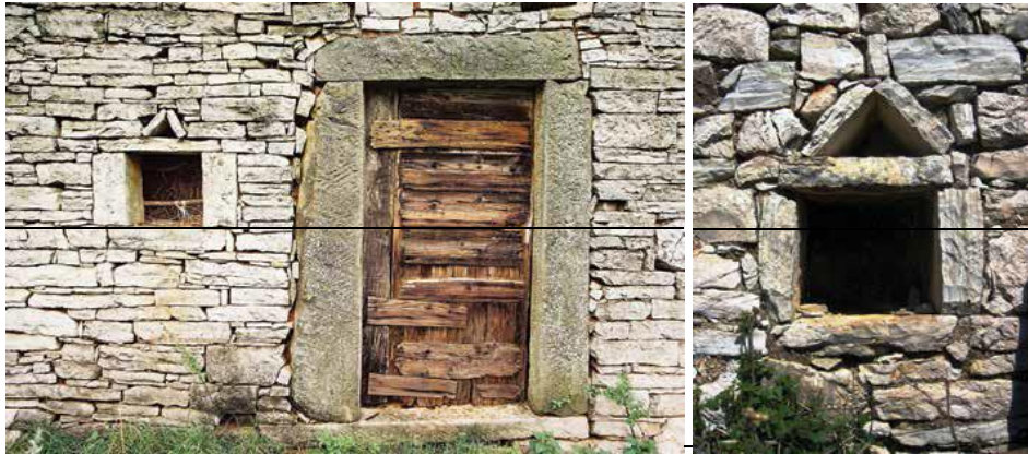
Slike 32.-33. Neobičan oteretni luk (kamen) nad vratima u Ostrogašici kod Uneši (lijevo); Detalj niše u vanjskom zidu kamene kuće (desno) 9
