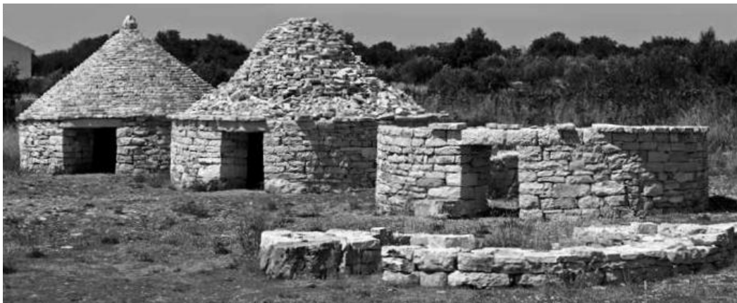
Slika 48. Park kažûna kod Salvele, uz sjeverozapadni ulaz u Vodnjan: kažûn prikazan u raznim fazama gradnje 2013. godine - temelji, zidovi, kupola, cjelovit kažûn 8
