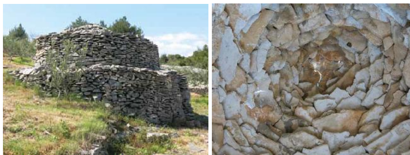
Slike 12.-13. Bunja u masliniku (lijevo) 11 ; Unutrašnjost krovne konstrukcije (desno) 11
