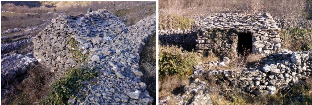
Slike 28.-29. Kamena kućica u selu Brotnice u Konavoskim brdima, Hrvatska 11 ; Pogled na spoj kućica na suhozid (lijevo) i pogled na ulazni dio (desno) 11
