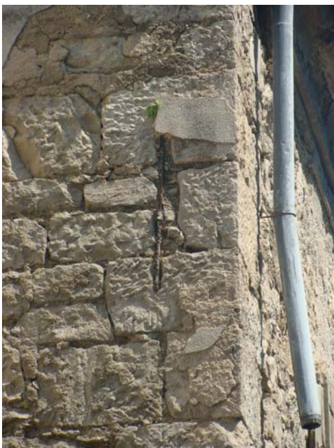
Slika 16. Kameni zidovi sa potresnom zategom
