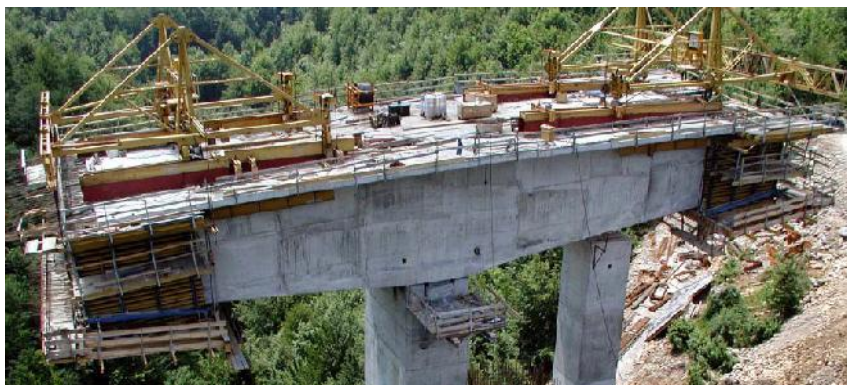
Slika 11. Postupno obostrano prepuštanje-konzolni postupak (7)
