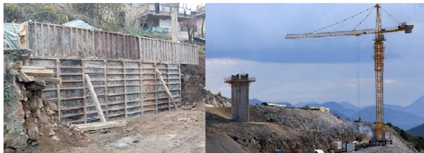
Slika 20. Armatura, oplata i betoniranje stupa i upornjaka (7)
