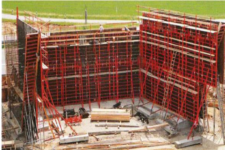
Slika 3. Gradnja upornjaka (7)
