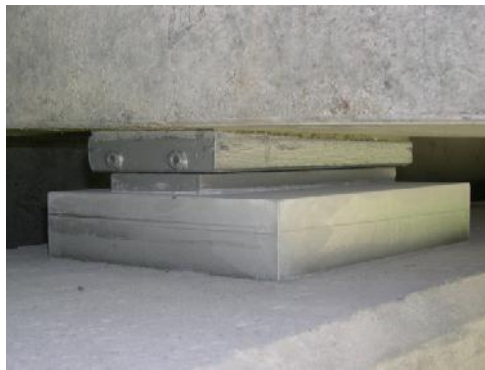
Slika 22. Ležajevi mosta (7)
