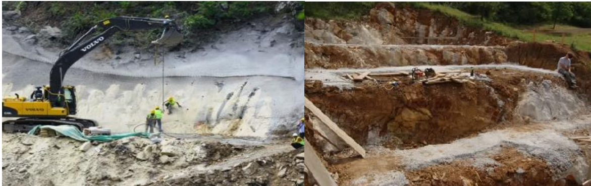
Slika 18. Strojevi na gradilištu i postavljanje podložnog betona (7)
