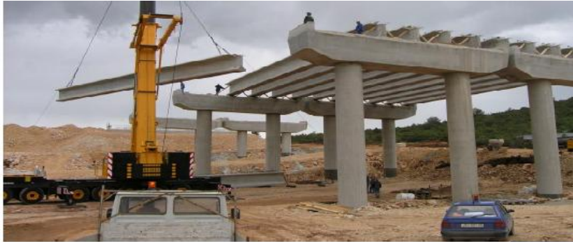
Slika 9. Predgotovljeni nosa i (7)
