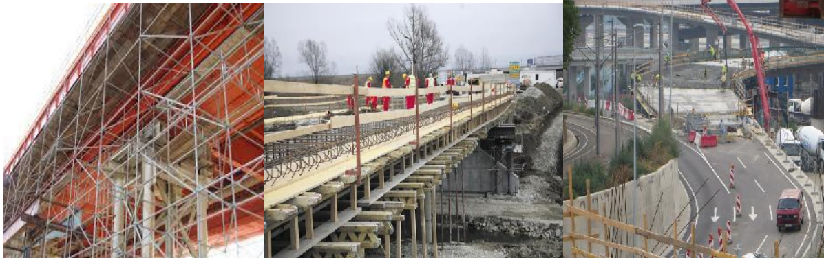
Slika 21. Cijevna skela, oplata, armatura i betoniranje rasponske konstrukcije (7)
