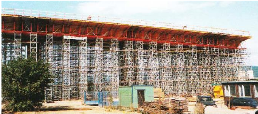
Slika 6. Laka cijevna skela (7)
