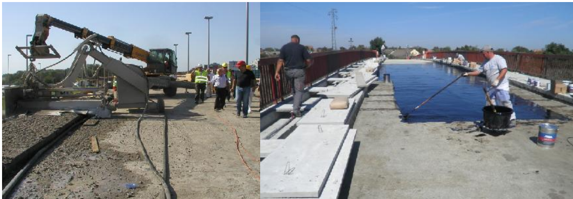
Slika 23. Instalacije mosta i hidroizolacija (7)
