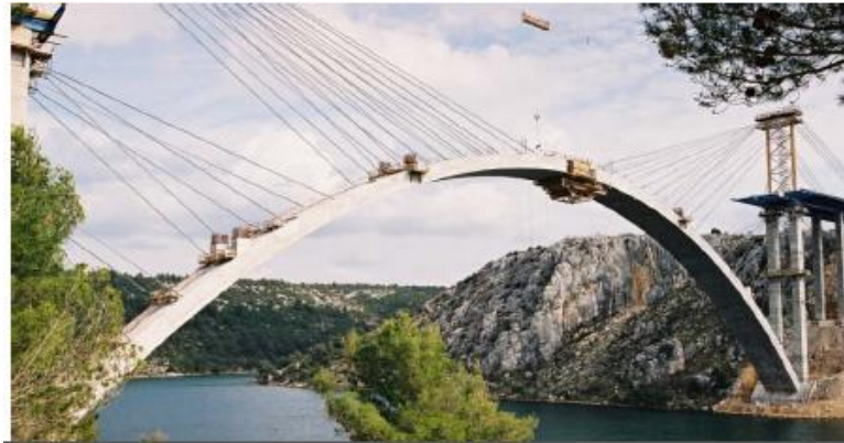
Slika 12. Gradnja luka pomo u zatega (7)
