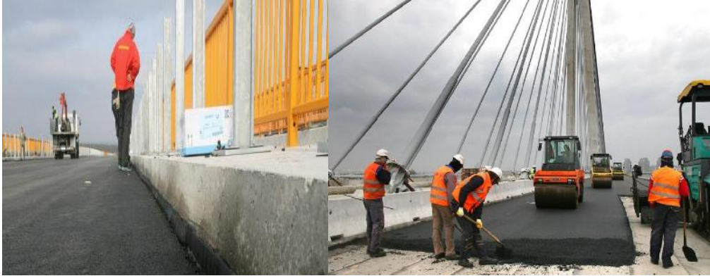
Slika 24. Rubnjaci i asfaltiranje (7)
