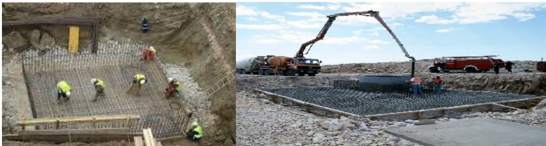
Slika 19. Armatura, oplata i betoniranje temelja stupa i upornjaka (7)
