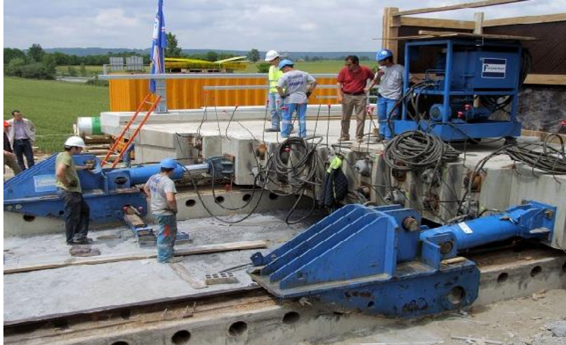
Slika 15. Postupno navlačenje naguravanje (7)
