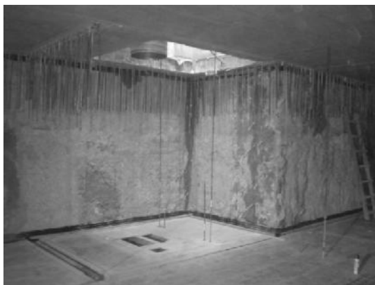
Slika 5. Procurivanje vode kroz pukotine ili loše dijelove betona
