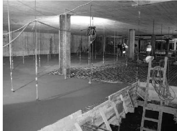
Slika 2. Betoniranje ploče
