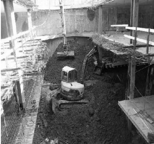
Slika 1. Iskop tla ispod buduće ploče
