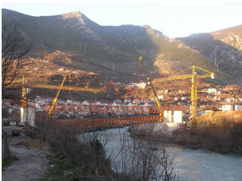
Slika 3. Montaža čeličnih rešetki na glavni raspon
