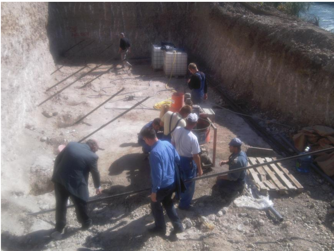
Slika 7. Izrada temelja riječnih stuba na lijevoj obali
