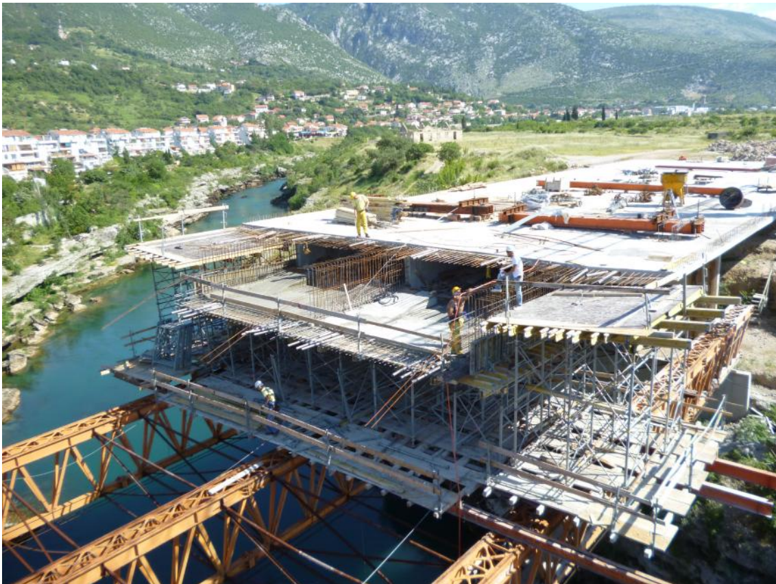
Slika 4. Izrada mosta u fazi III
