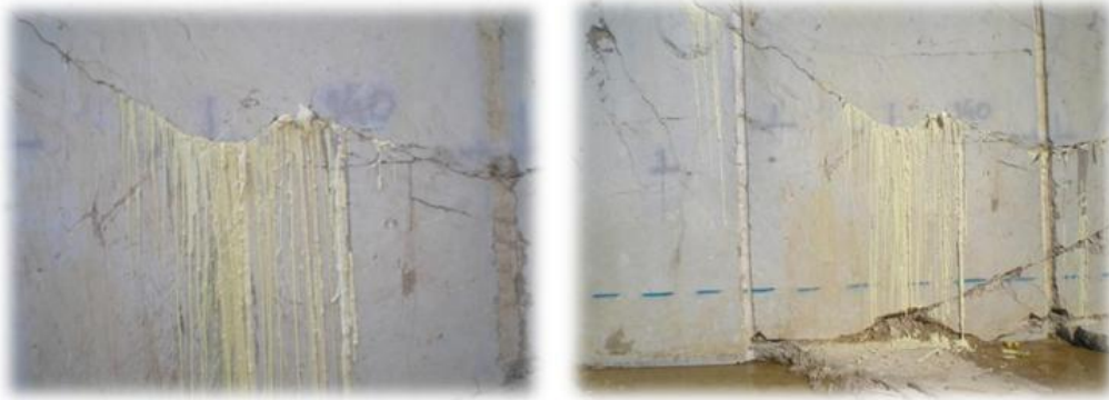
Slika 11. Izgled čela etaže nakon utiskivanja u bušotine
