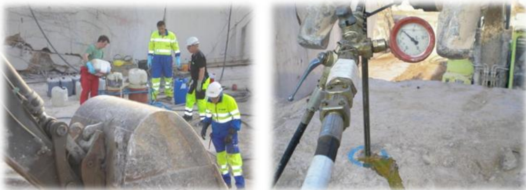
Slika 10. Utiskivanje vezivne smole u utisnu bušotinu
