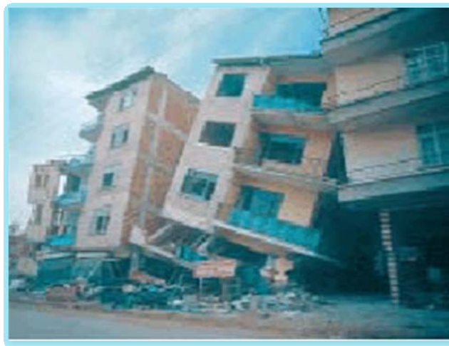
Slika 6. Primjer rušenja objekta zbog tzv. „mekanog prizemlja”
