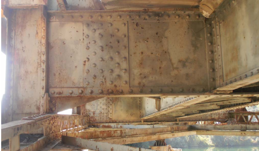
Slika 4. Poprečni nosač na mostu u Gabeli
