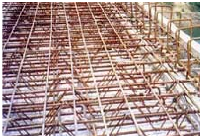
Slika 38. Ugrađena armatura
