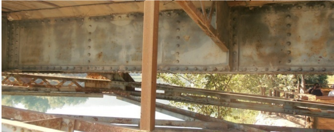
Slika 2. Podužni nosač mosta u Gabeli
