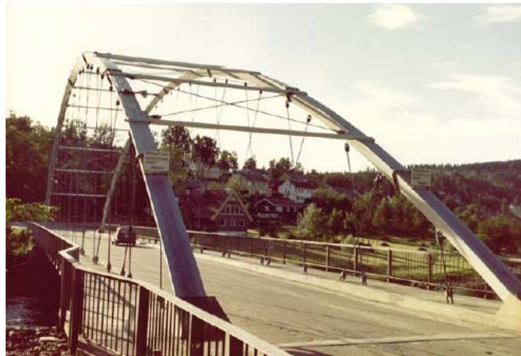
Slika 6. Vjetrovni spreg rešetkastog lučnog mosta prilagođenog domaćim važećim propisima
