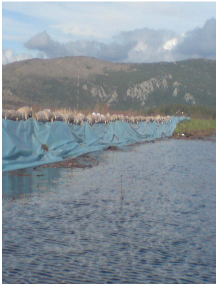
Slika 2. Desni nasip uz rijeku Krupu (općina Čapljina)
