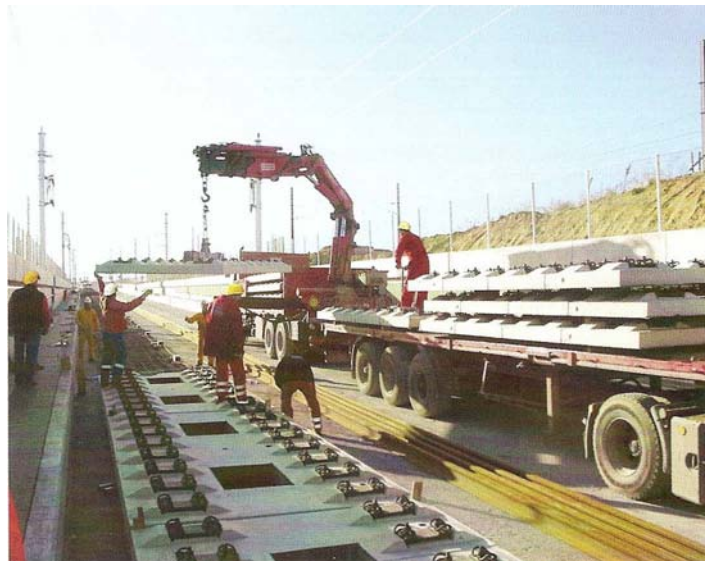
Slika 15. Polaganje podložne ploče za tračnice pomoću kamiona
