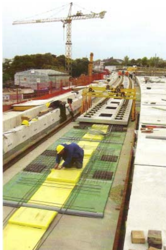
Slika 23. Polaganje elastomera
