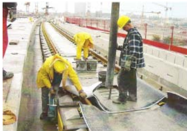
Slika 16. Zalijevanje (betoniranje) podložne ploče sa SCC-om
