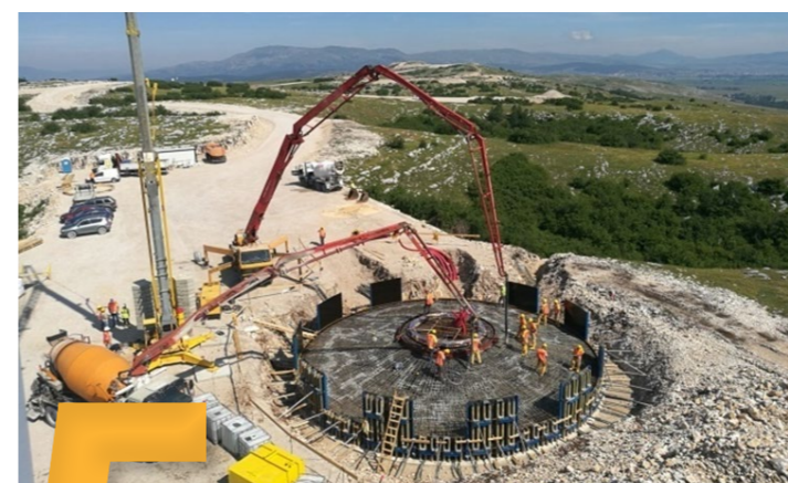
Betoniranje temelja Prosječno trajanje ugradnje betona 10-11 sati Betonara udaljena oko 8 km od gradilišta
