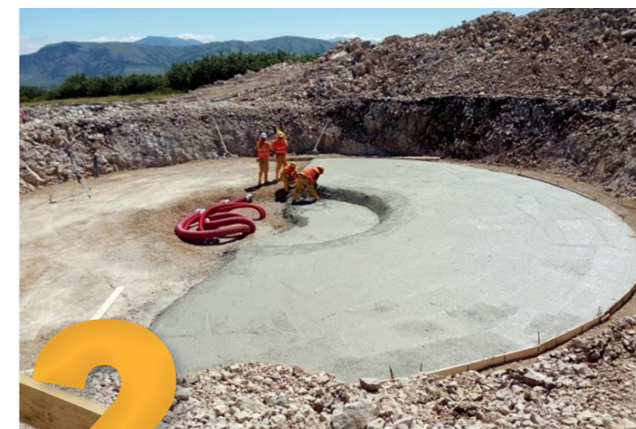
Ugradnja podložnog betona Debljina 10 cm, 260 m 2
