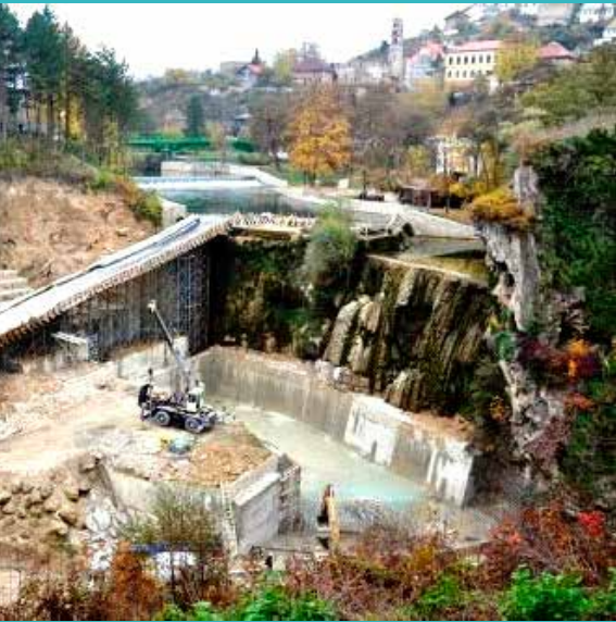
Izvođenje radova na sanaciji vodopada
