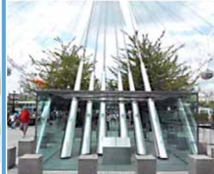
Pomoćni pozadinski kabeli pričvršćuju A-okvir
