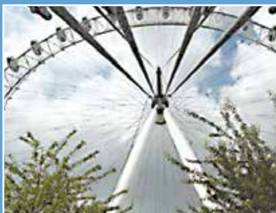
A-okvir položen je između osovine i stipa stupa
