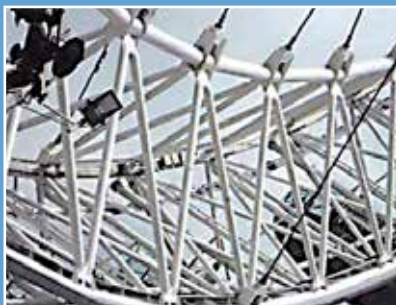
Čelični okvir trokutaste rešetkaste konstrukcije
