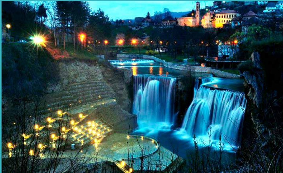
Sadašnji izgled vodopada, nakon završene sanacije
