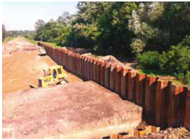
Zaštitna građevina u Račinovcima, talpe
