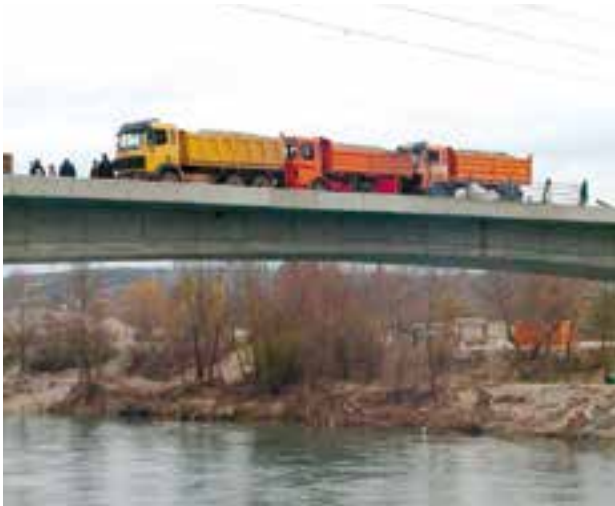
Ispitivanje glavnog raspona mosta
