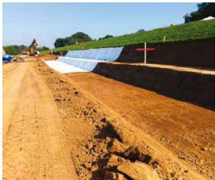
Zasijecanje postojećeg nasipa, odstranjivanje loših dijelova i ugradnja novog, geotekstil
