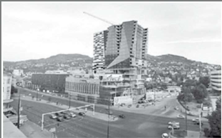
Sarajevo City Center u fazi izvođenja
