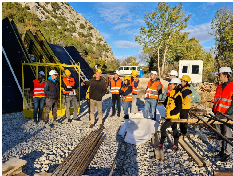
Slika 4. 1. Terenska nastava – Posjet gradilištu mosta Počitelj
