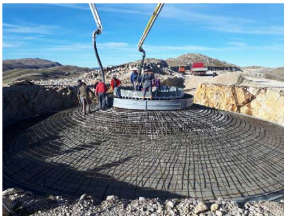
Slika 10.3 Stručni nadzor betoniranja temelja vjetroturbine na Vjetroelektrani Jelovača
