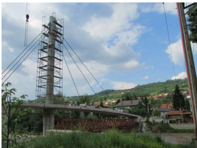
Slika 10.2 Ispitivanje pješačkog mosta preko rijeke Bosne u Visokom
