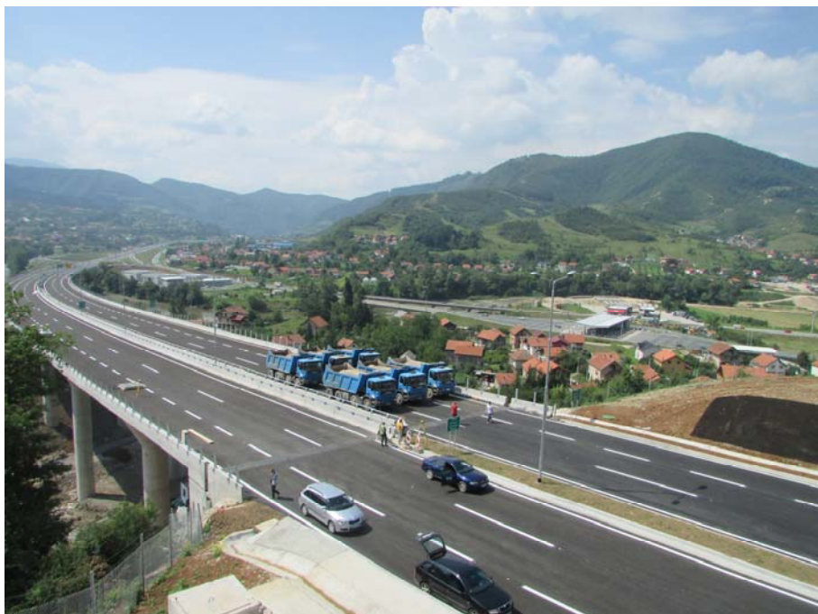
Slika 12.3 Ispitivanje probnim opterećenjem konstrukcije mostova "Drivuša" i "Perin Han"
